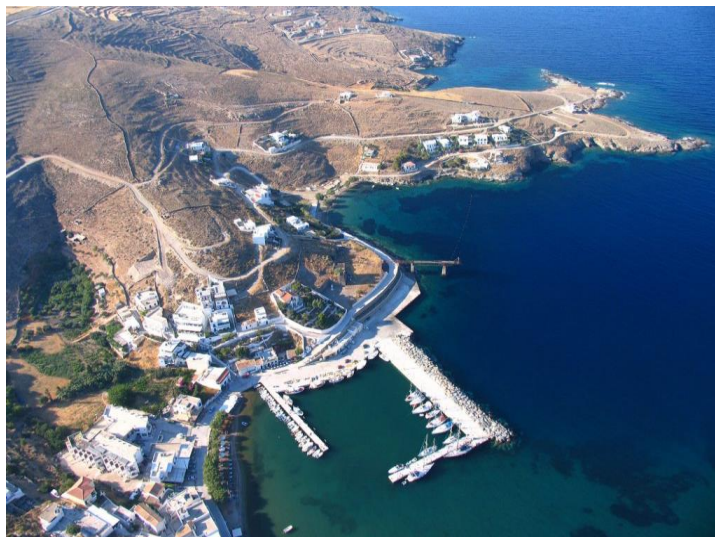
Εικόνα 3-28: Λιμενική εγκατάσταση Λουτρών
