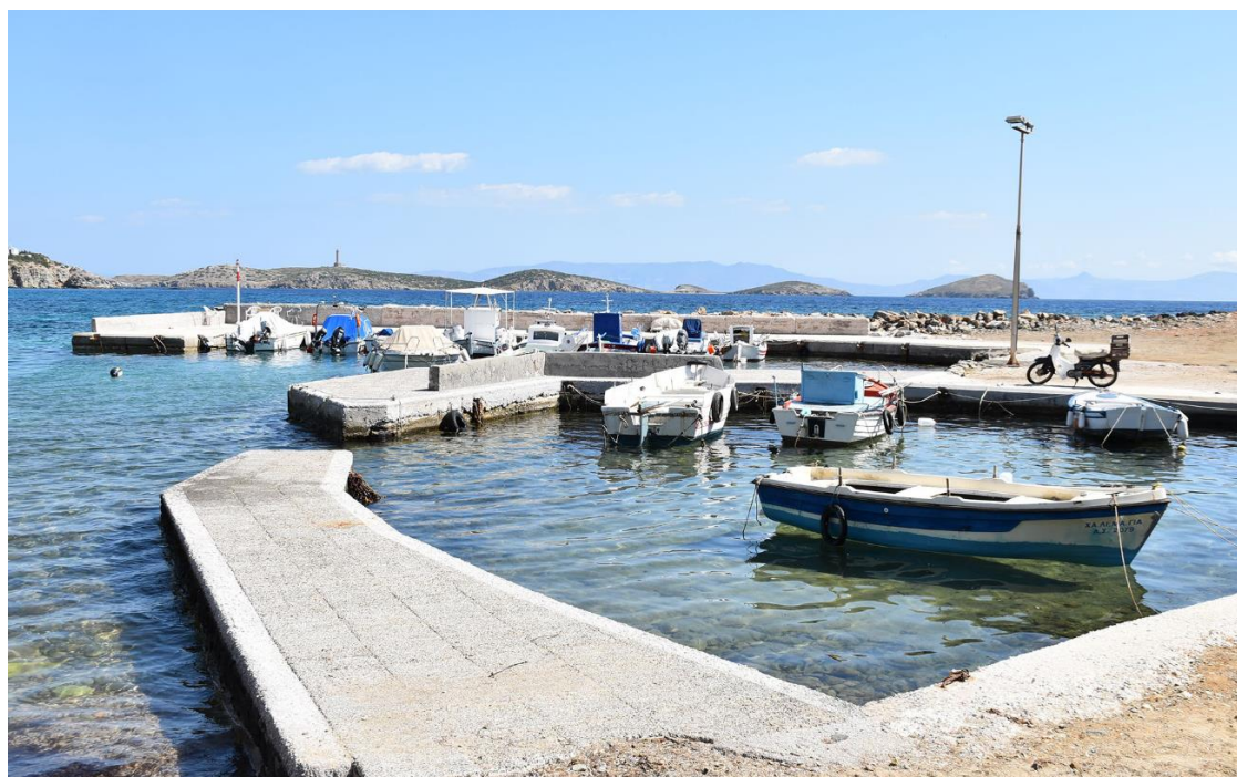
Εικόνα 3-11: Άποψη αλιευτικού καταφυγίου "Αζόλιμνος"
